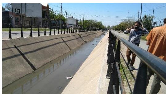
**Imagen 33. Canalización revestida sobre Diomedes, descarga hacia Arroyo Del Rey**
